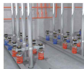
방진 스프링 설치 완료
