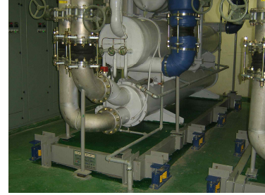
-장비 하부 스프링 방진스프링 마운트 설치 도면 및 설치 모습-
