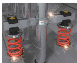
스프링 하부 용접
