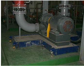
-흡입 토출 배관 펌프 방진베이스에 고정 설치 모습-
