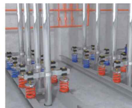
방진 스프링 설치 완료
