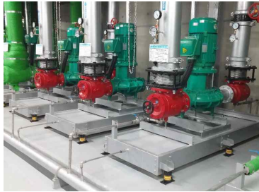
-흡입 토출 배관 펌프 방진베이스에 고정 설치 모습-
