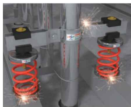
스프링 하부 용접
